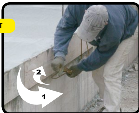
Décoffrage ultra-rapide grâce à son point de rupture en retrait
